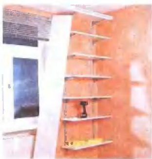
Навесные полки на кронштейнах и с направляющей со стороны окна обшиты ламинированной ДСП.
