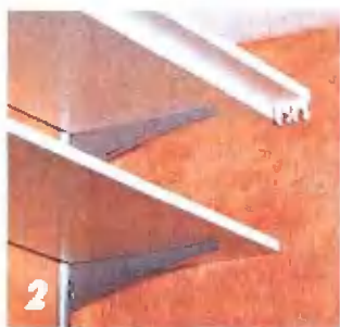
Глубина верхней, идущей по всей стене, полки на 10 см больше нижних. На свесе закреплены фиксаторы для четырех медных трубок.
