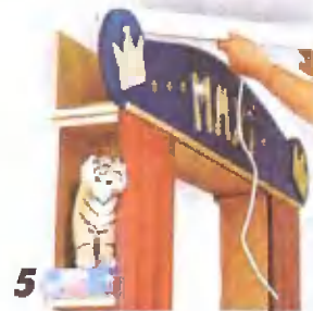
На полке над дверью устанавливают лампу дневного света, подчеркивающую вырезы и вензель.
