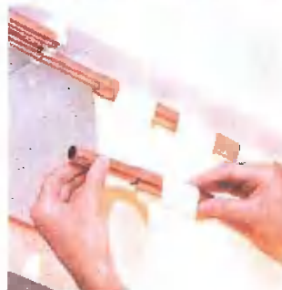
Трубку-направляющую Ø18 мм вставляют в медную трубку Ø22 мм, а затем крепят в фиксаторах.
